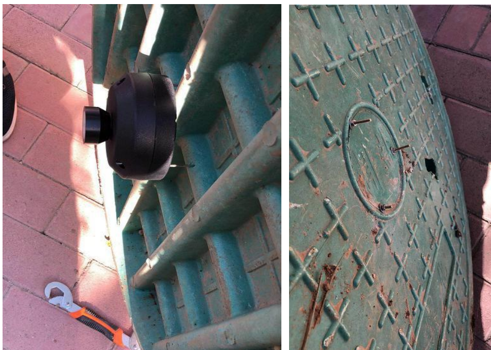
Рис. 7 Установка датчика на крышку люка
